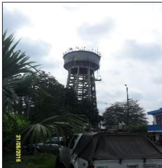
Imagen 2-15 Tanque de Almacenamiento
