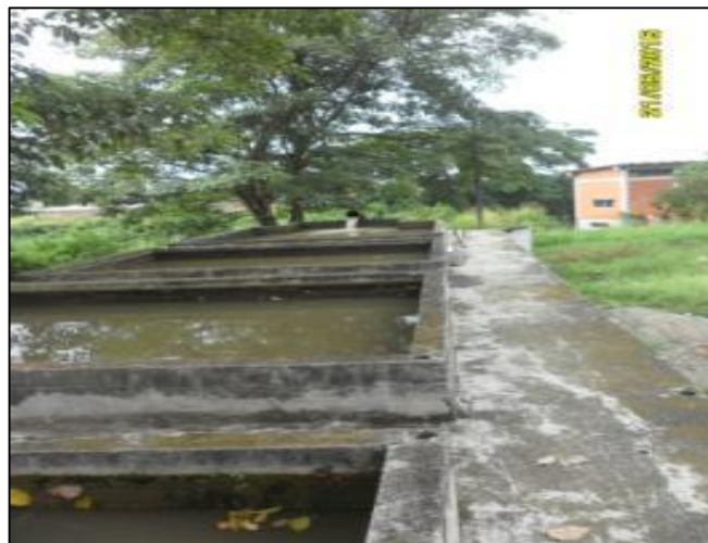
Imagen 2-4 Desarenador municipio de Puerto Tejada
