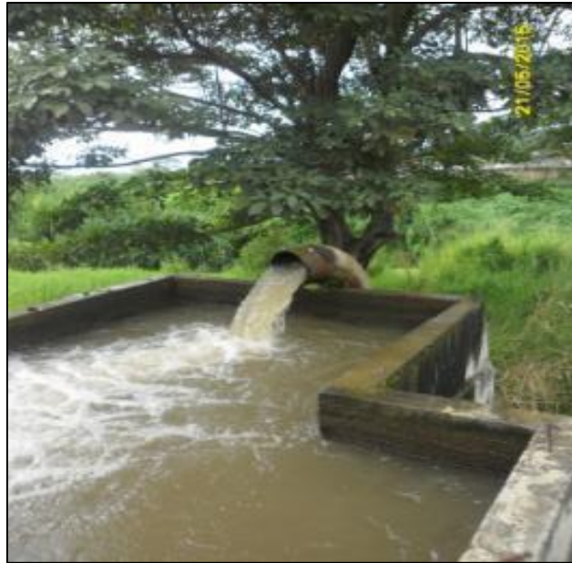
Imagen 2-5 Detalle entrada de agua al desarenador
