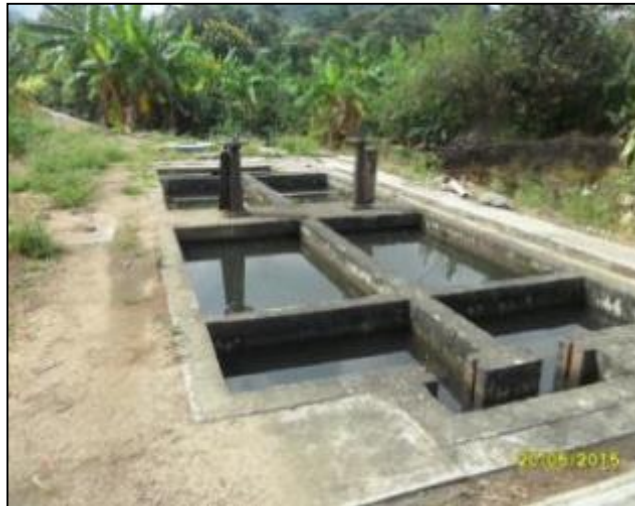
Imagen 1-3 Desarenador municipio de Padilla
