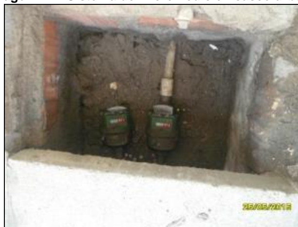
Imagen 1-11 Sistema de micromedición casco urbano
