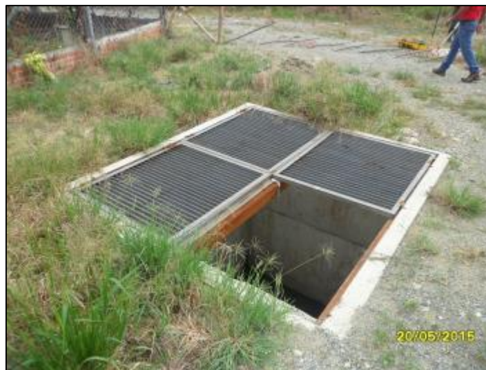
Imagen 1-12 Cámara de Cribado PTAR Municipio de Padilla
