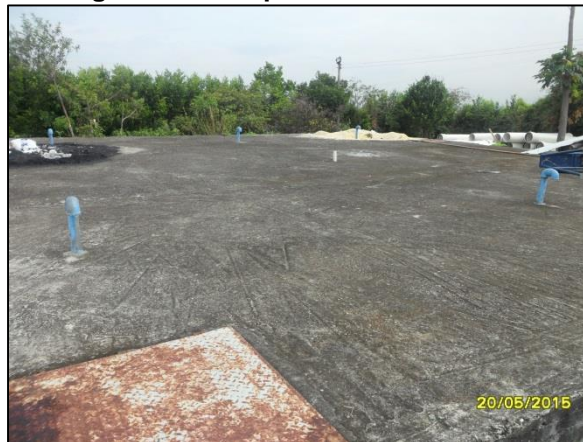
Imagen 1-10 Tanque de almacenamiento
