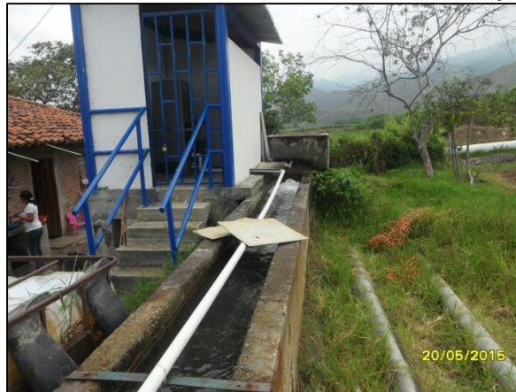
Imagen 1-4 Caseta dosificador de sulfato de aluminio y cal (nueva)
