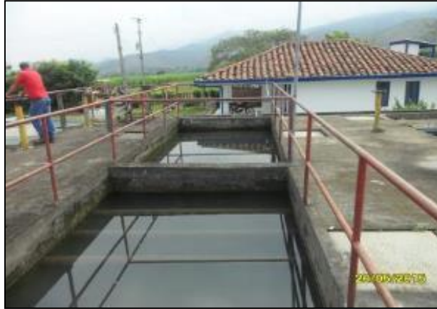
Imagen 1-9 Sedimentador de alta tasa
