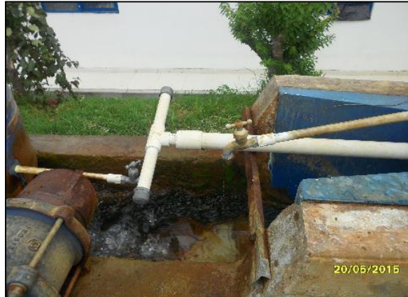
Imagen 1-7 Mezcla rápida con resalto hidráulico
