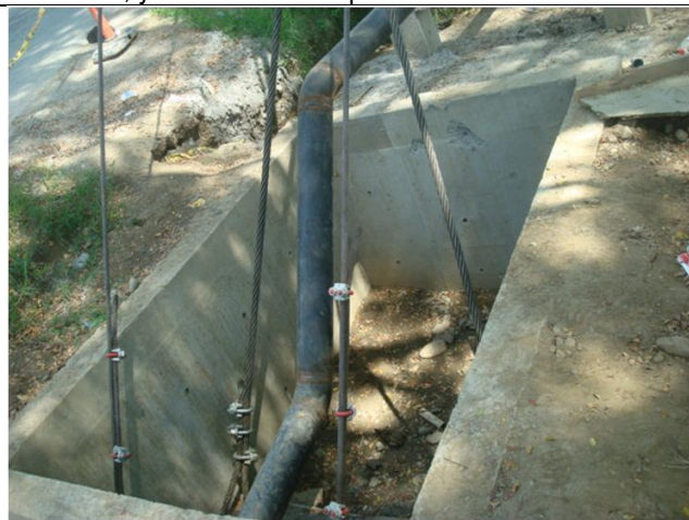
Se termina de hacer los empalmes de la tubería de acero al carbón con la de PVC, resta la prueba hidraulica
