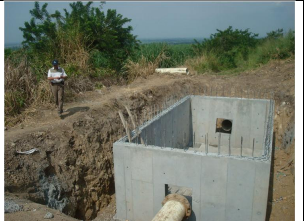
Se inicia la construcción de la estación reductora de 20", lo que corresponde a la obra civil.
