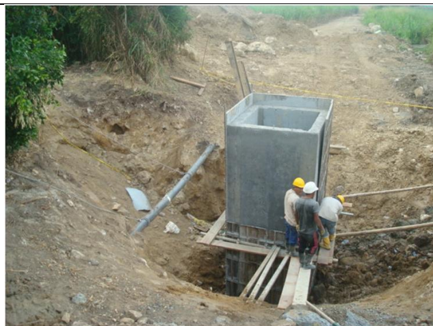
Se construye la caja de salida de desagües donde se direcciona el desagüe proveniente de la PTAP
