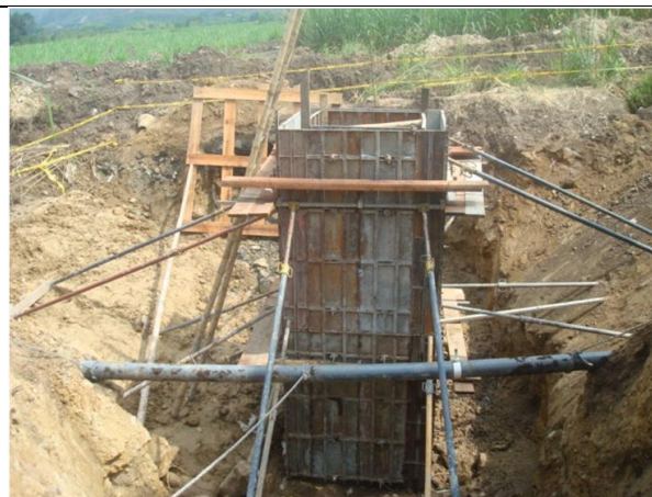
Se construye la caja de salida de desagües donde se direcciona el desagüe proveniente de la PTAP
