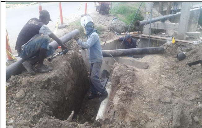
En la línea de 6" se termina de izar la tubería Acero al Carbón y se colocan las péndolas para dar equilibrio a la estructura, y se hacen los empalmes con la red de 6" PVC
