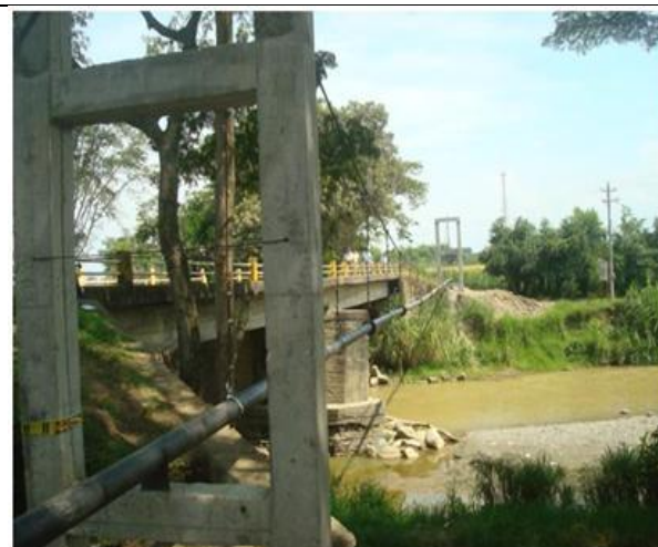
Se termina de hacer los empalmes de la tubería de acero al carbón con la de PVC, resta la prueba hidraulica
