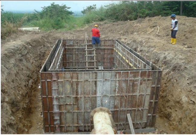
Se inicia la construcción de la estación reductora de 20", lo que corresponde a la obra civil.
