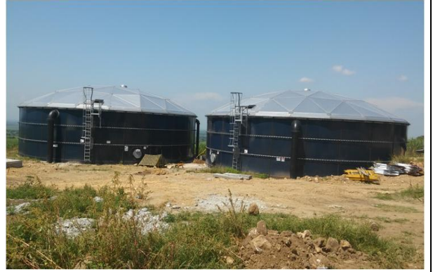
En estos tanques se hace la desinfección interna.
