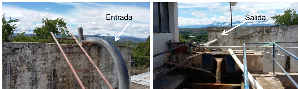
Foto 1 Desarenador existente – ubicación de tuberías de entrada y salida
