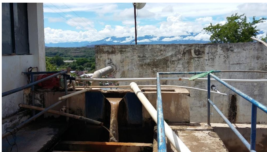
Foto 2 Vertedero para mezcla rápida
