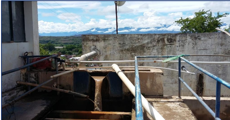
Foto 7 mezcla rápida existente
