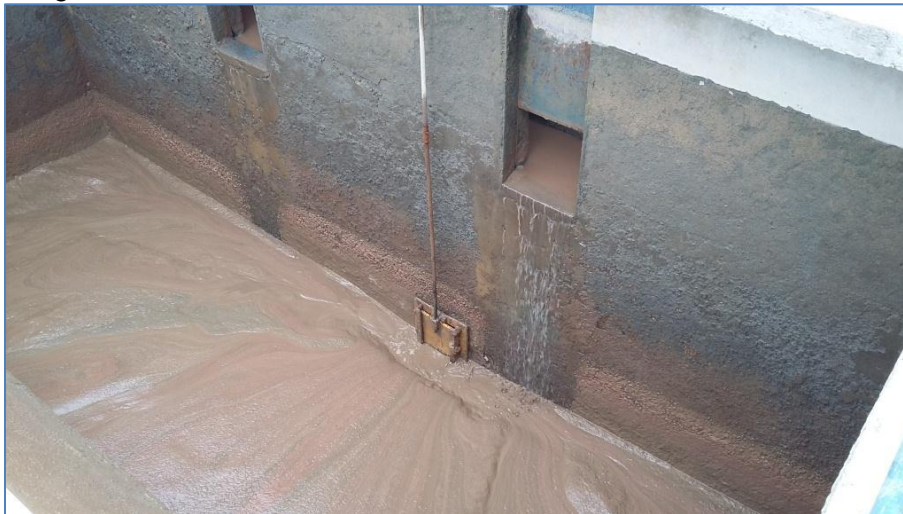
Foto 10 Sistema de drenaje de sedimentadores
