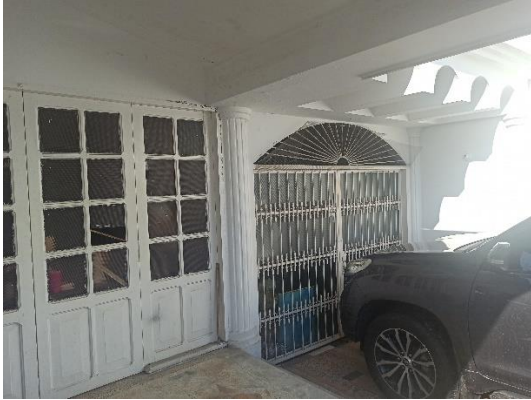
Foto 4. Puerta de ingreso al garaje
