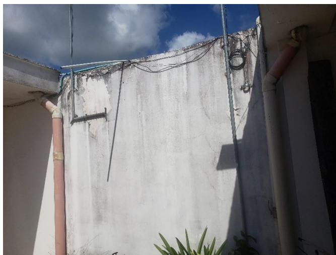
Ilustración 5. deterioro de pintura muros de patio
