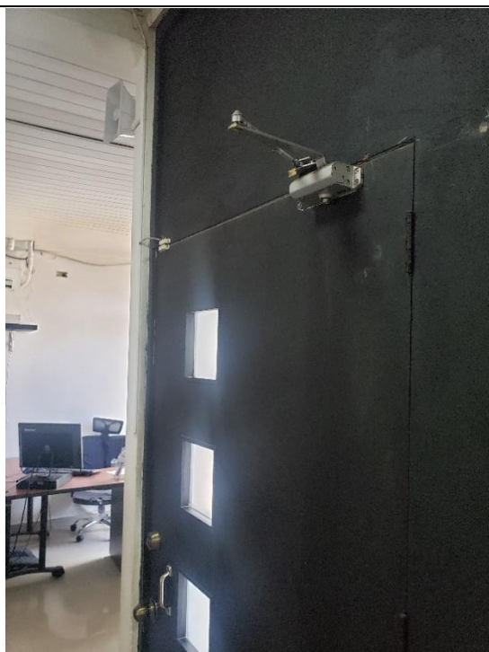
Ilustración 17. Puerta Acceso principal, y brazo hidráulico para mantenimiento.
