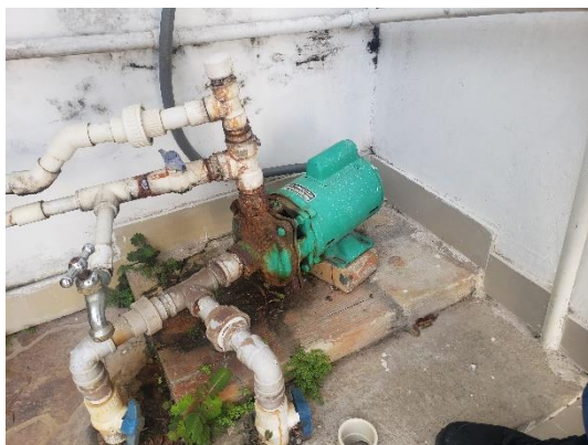
Ilustración 20. Motobomba, suministro principal de agua
