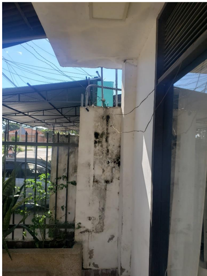
Ilustración 14. Humedad muro acometida eléctrica
