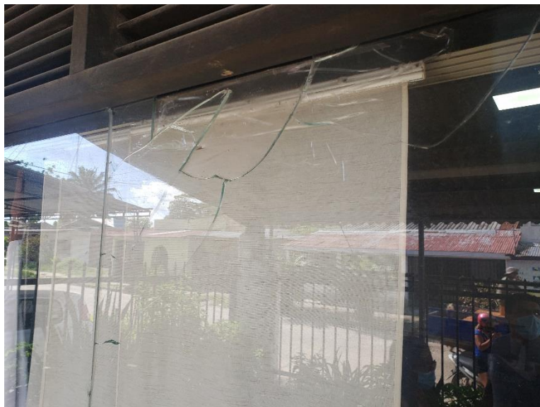
Ilustración 13. Vidrio roto en fachada principal
