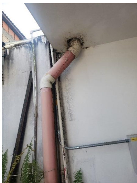
Ilustración 21. Humedad en bajantes de agua
