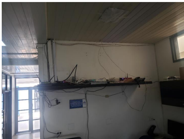
Ilustración 11. Estado de cableado estructurado de Vos y Datos
