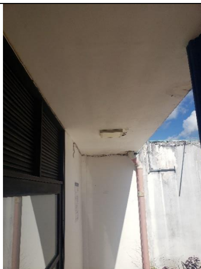
Ilustración 19. Humedad cielorraso, muros y estado de bajantes
