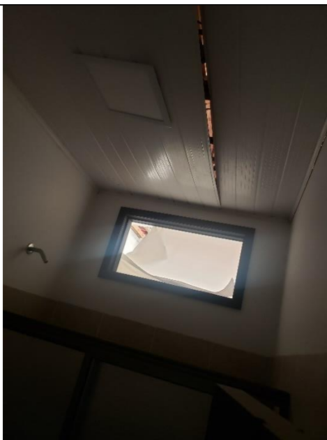
Ilustración 10. cielorraso desprendiéndose de baño
