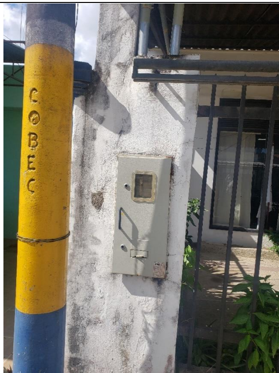
Ilustración 15. Tapa de contador luz desprendido
