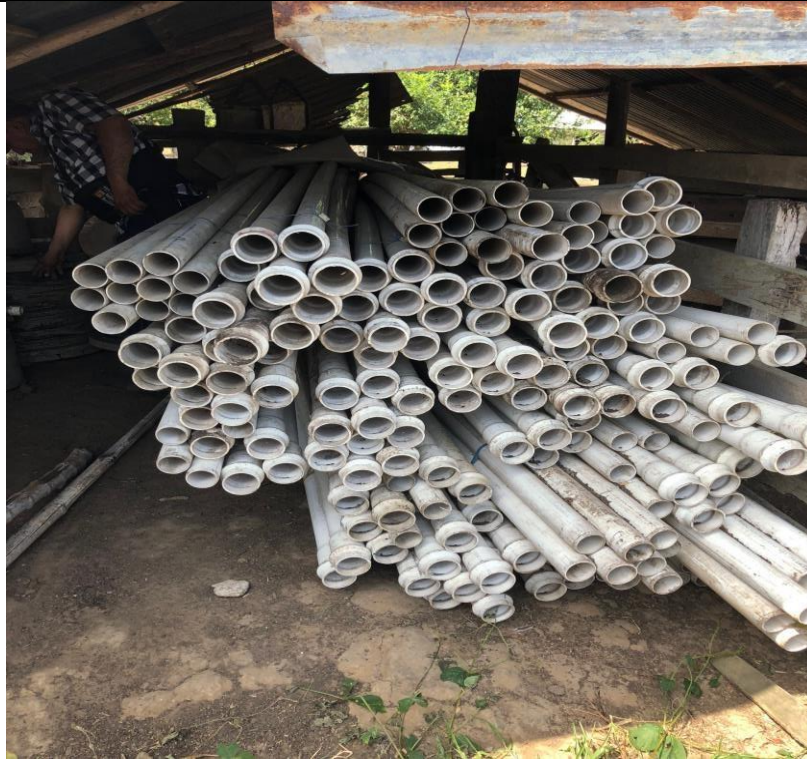
Tubería de PVC RDE 21, Red matriz del sistema de Riego Almacenada
