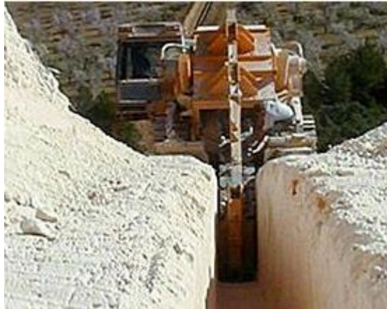
Figura 4. Método de zanja abierta con máquina
