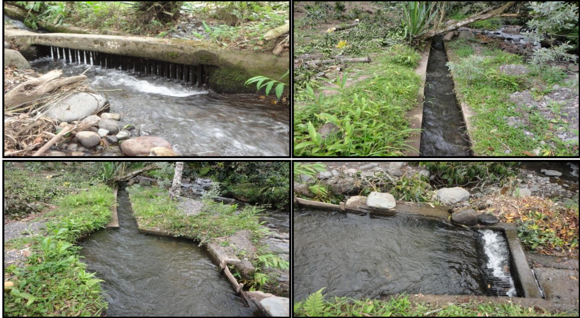
Figura 11. Rejilla de Cribado, Canal de Acceso y Bocatoma de Fondo
