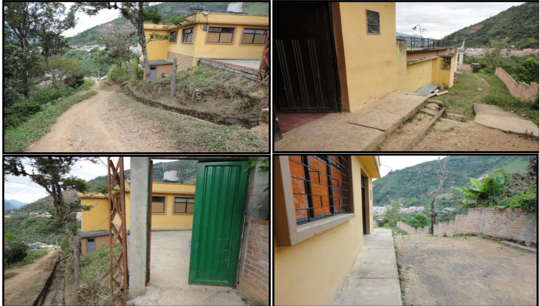
Figura 15. Planta de Tratamiento de Agua Potable
