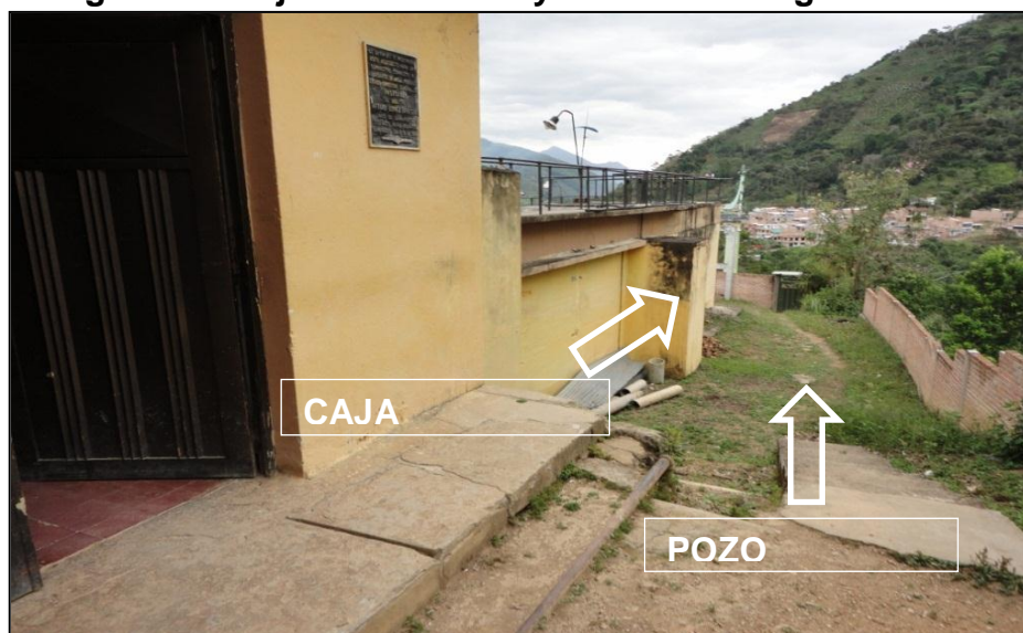
Figura 36. Caja Recolección y Evacuación Aguas PTAP
