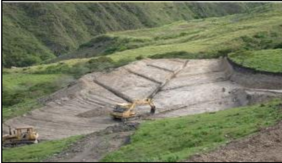
Figura 44. Sistema Recolección y Evacuación Lixiviados
