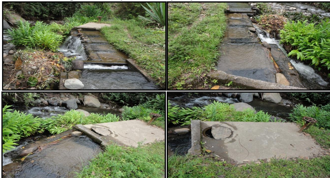
Figura 12. Rejilla, Canal y Caja de Recolección
