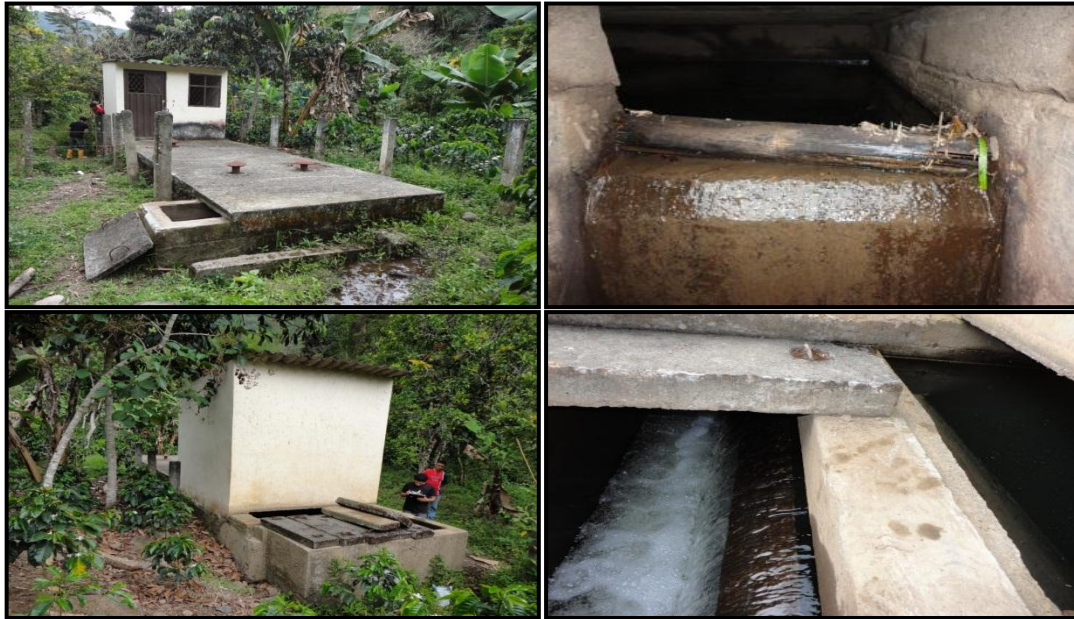
Figura 13. Desarenador y Componentes Constitutivos de la Estructura
