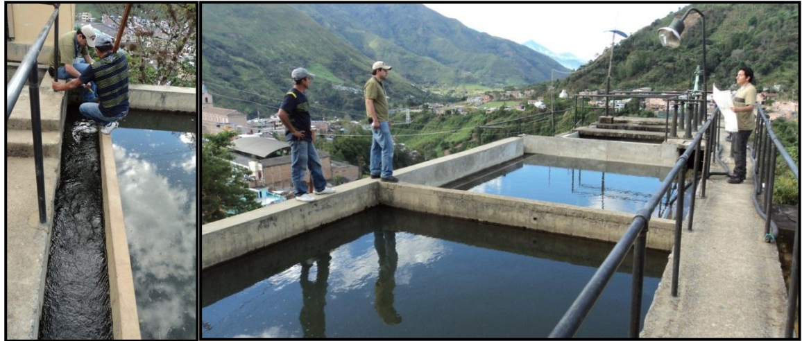
Figura 21. Estructura de Sedimentación
