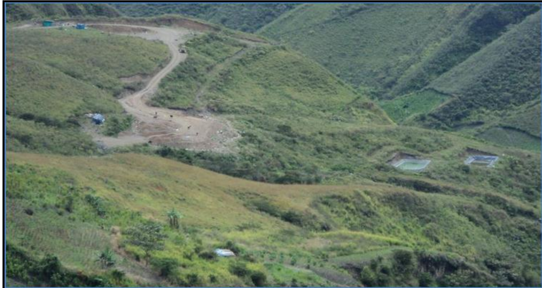
Figura 39. Vista General Relleno Sanitario “El Balso”
