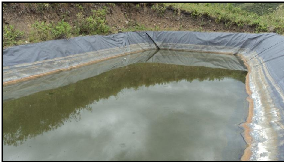
Figura 46. Laguna Facultativa Relleno Sanitario
