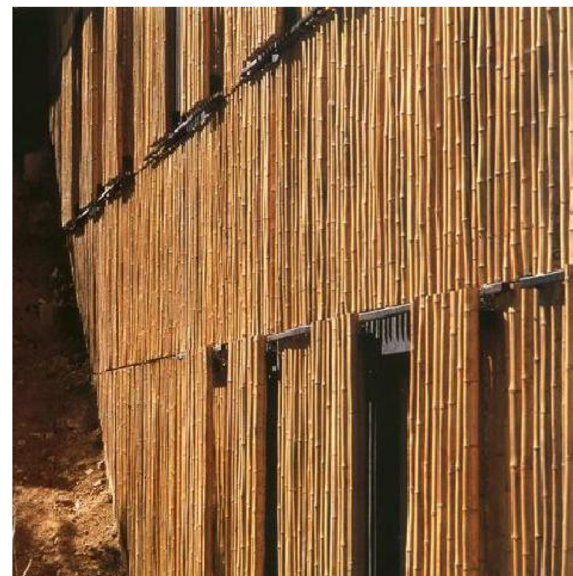
REVESTIMIENTO DE GUADUA Y ADAPTACIÓN A LAS ABERTURAS
