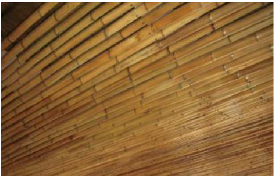
FALSO TECHADO DE GUADUA PROTEGIDO CON REVESTIMIENTO TEXTIL IMPERMEABLE DE PVC REFORZADO Y PROTECCIÓN PVD
