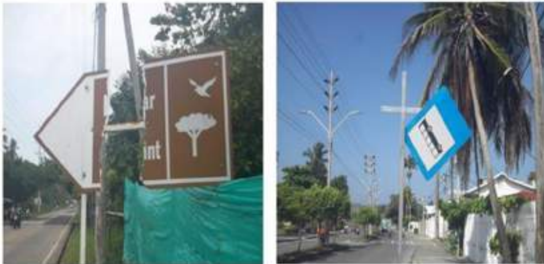
Imagen 64 - Señales de tránsito en mal estado
