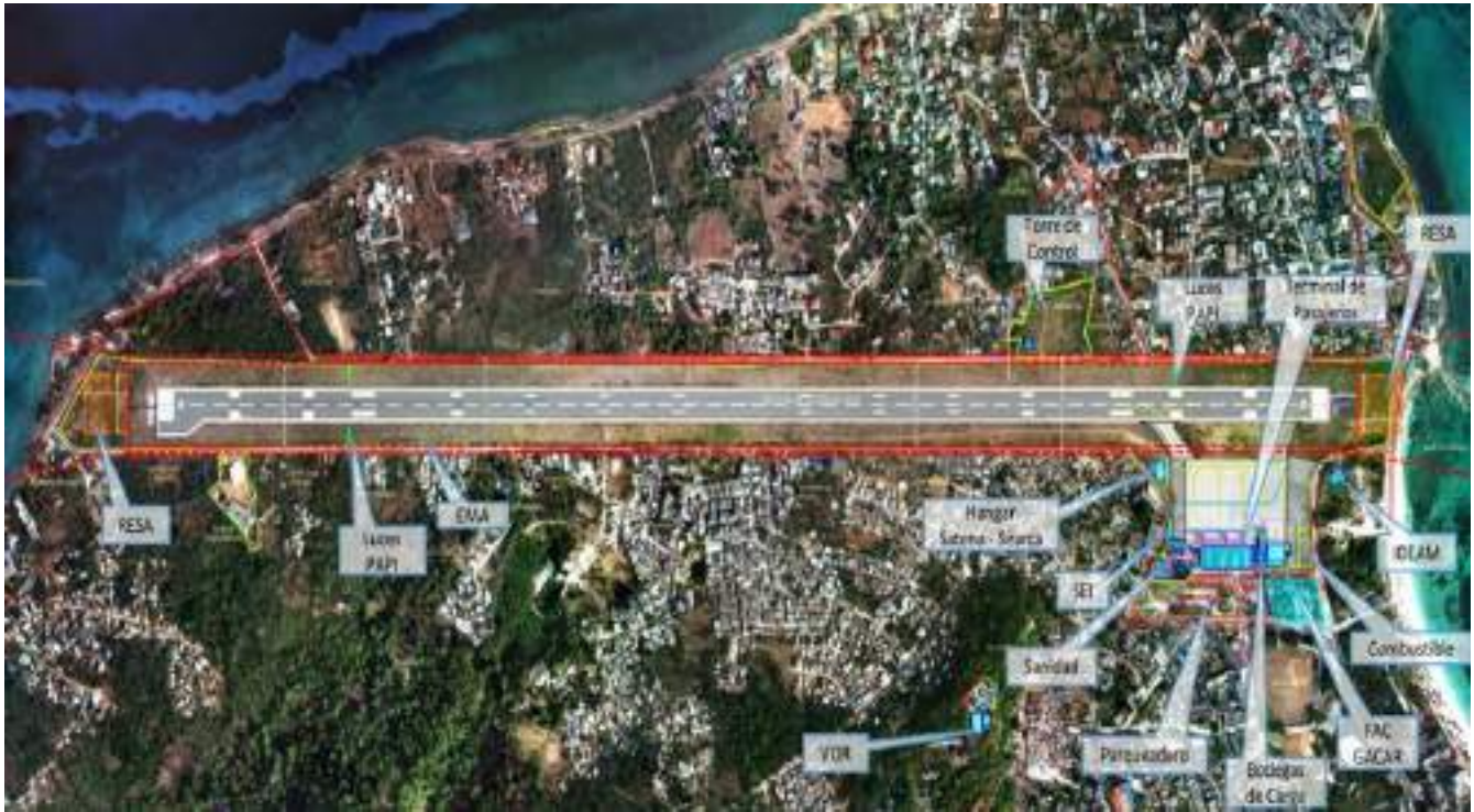
Ilustración 3 - Infraestructura actual del Aeropuerto Gustavo Rojas Pinilla, San Andrés
