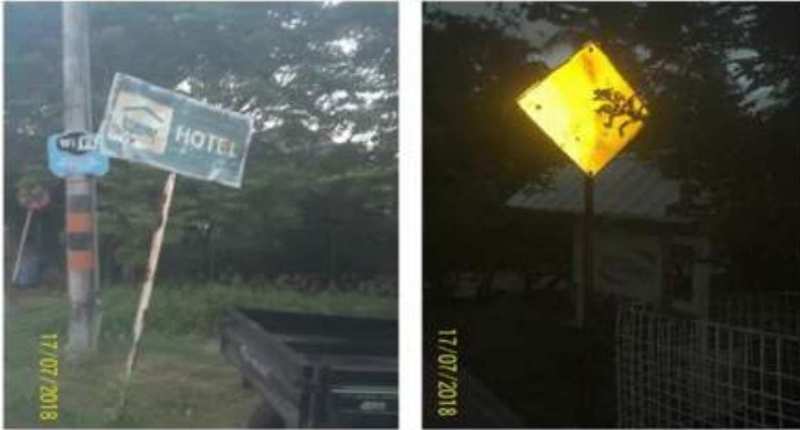
Imagen 73 - Señalización en mal estado, Providencia
