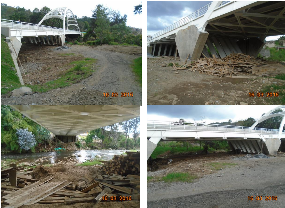
Figura 2 estado actual del Puente Nuevo sobre el Río Cauca
