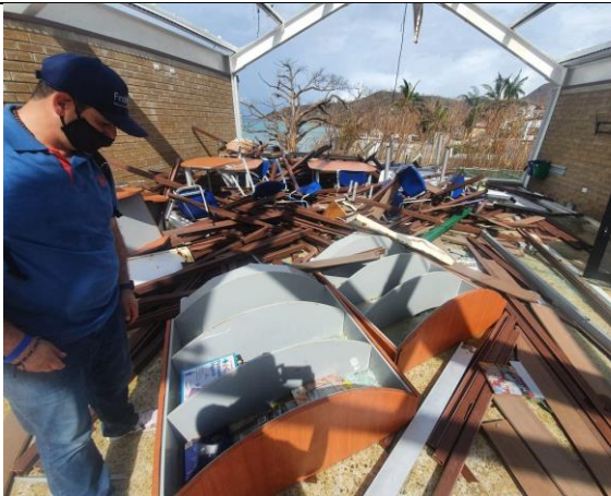
Fotografía 9. Estructura liviana y cubierta destruidas.
