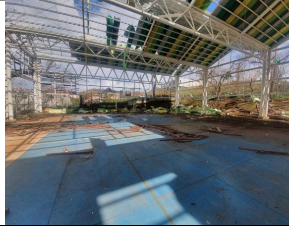
Fotografía 16. Afectación en cerramiento perimetral en madera plástica.
