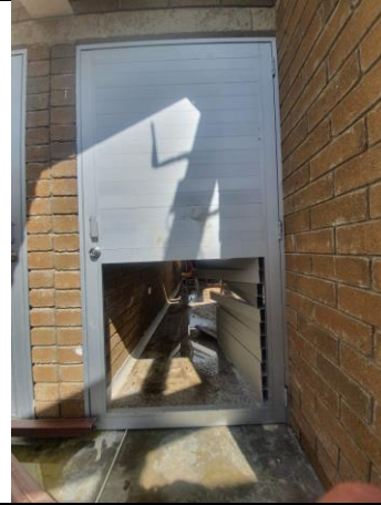
Fotografía 12. Puertas en aluminio Afectadas, o vandalizadas al tomarse el colegio como refugio por parte de la población.
