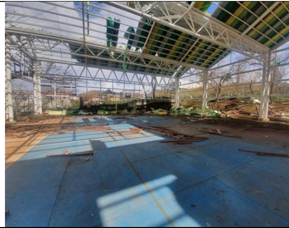
Fotografía 16. Afectación en cerramiento perimetral en madera plástica.
