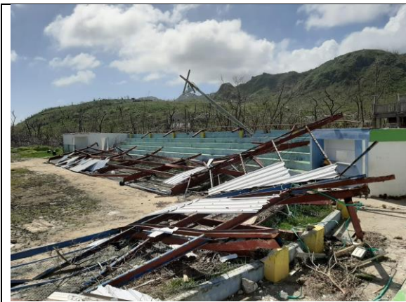
Fotografía 27. Afectación en graderías cancha de softball de La Montaña.
