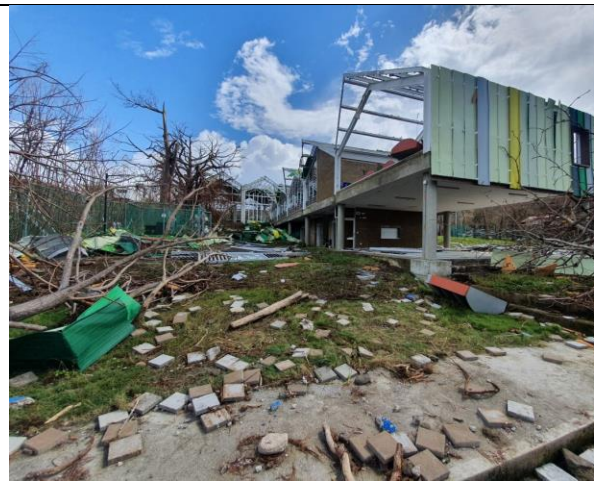
Fotografía 2. Afectaciones en el Urbanismo y cubierta del colegio.
