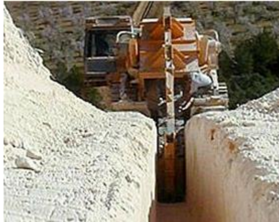
Figura 3. Método de zanja abierta con máquina
