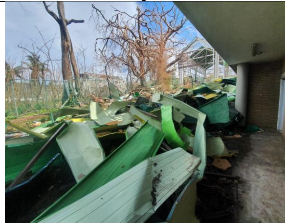
Fotografía 4. Daño total en la carpintería metálica y estructura liviana del Colegio.
