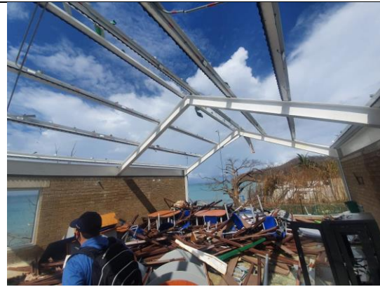
Fotografía 8. Estructura liviana y cubierta destruidas.
