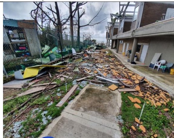
Fotografía 22. Muro de salida a zona de recreación en preescolar afectado producto de la caída del cerramiento, donde se confinaba dicho muro.
