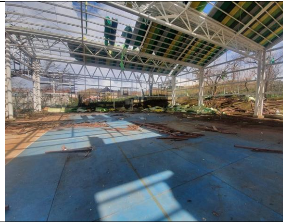
Fotografía 16. Afectación en cerramiento perimetral en madera plástica.
