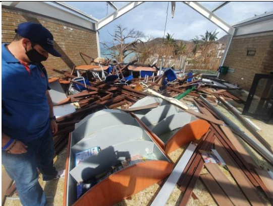
Fotografía 9. Estructura liviana y cubierta destruidas.
