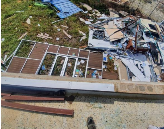
Fotografía 5. Lodos al interior de la infraestructura producto del huracán.
