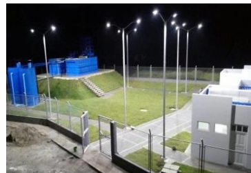
ACUEDUCTO - PLANTA AGUA POTABLE GUALMATÁN, NARIÑO
