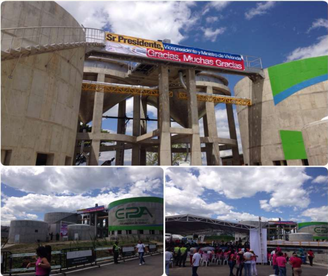
Armenia, Quindío Construcción Ptar la marina Valor: $17.304 millones Población beneficiada: 191.698 habitantes
