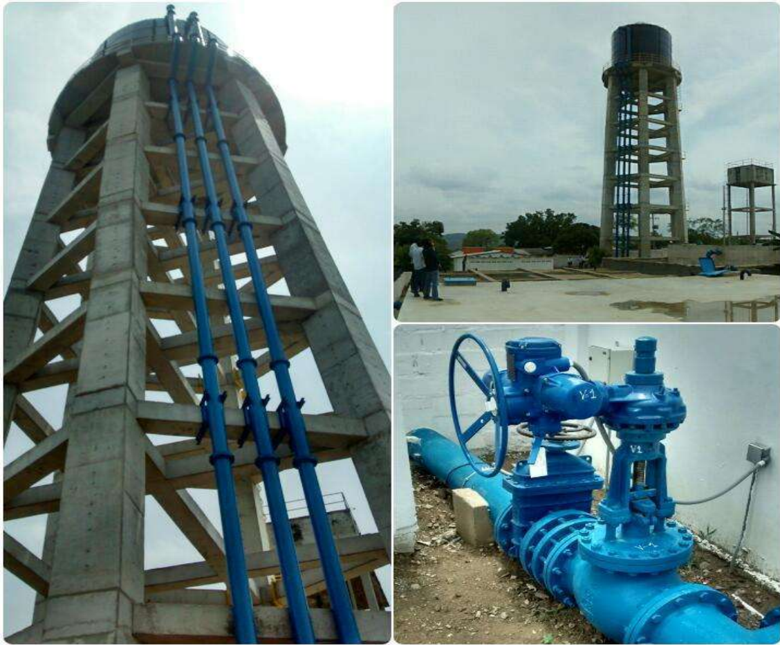
Carmen de Bolívar, Bolívar Optimización Sistema de Acueducto Valor: $37.215 millones Población Beneficiada: 56.348 Habitantes
