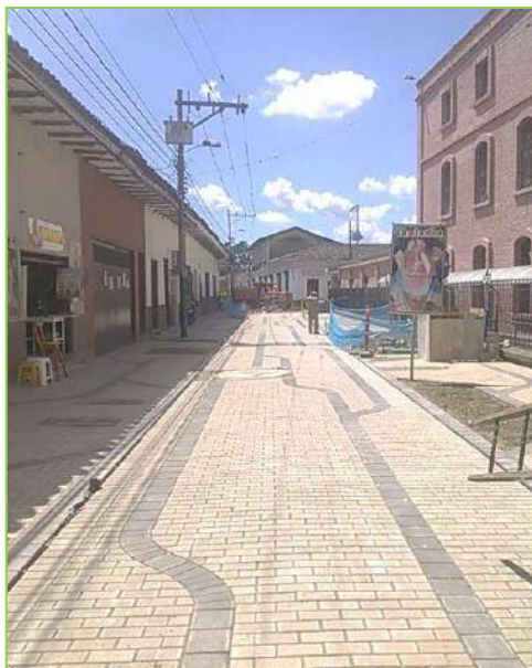
Imagen Instalación del Adoquín
