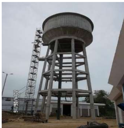
Cartagena, Bolívar REHABILITACIÓN DEL SISTEMA DE BOMBEO DE LOS POZOS NUMERO UNO Y DOS DEL SISTEMA DE ACUEDUCTO Valor: $10.000 millones Población Beneficiada: 21.856 habitantes
