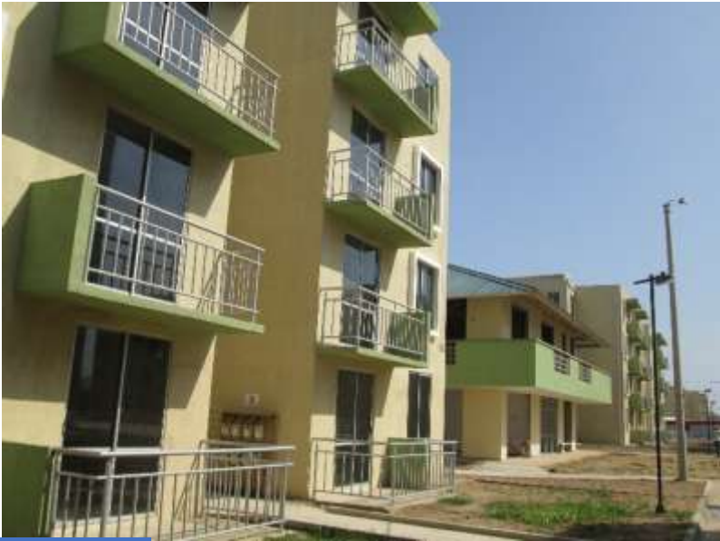
VILLAS DE SAN PABLO Barranquilla, Atlántico (832 viviendas)
