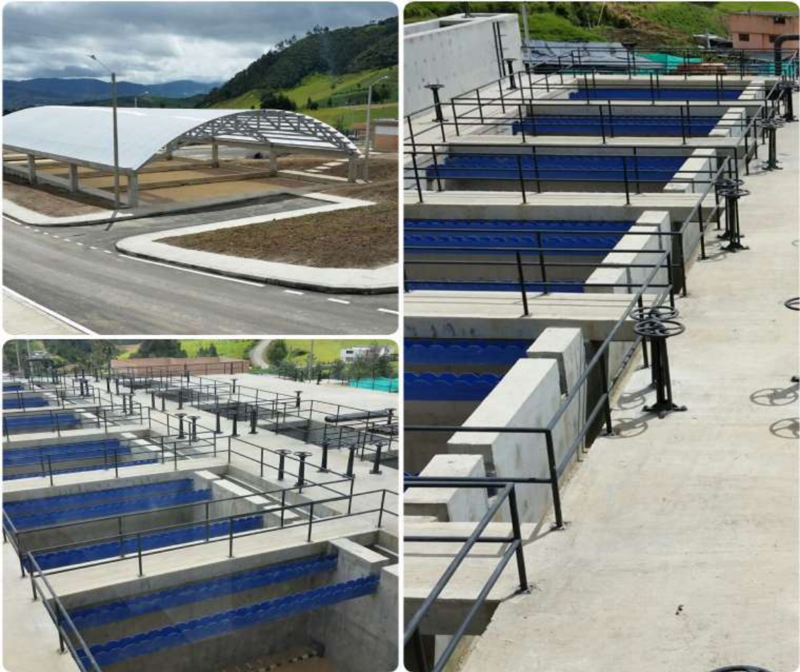
Pasto, Nariño Construcción Ptar Quebrada Piedras Fase2 Valor: $30.424 millones Población Beneficiada: 23.139 Habitantes
