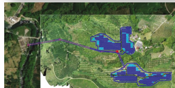
↓ Imágenes del proyecto fotovoltaico San Francisco.
