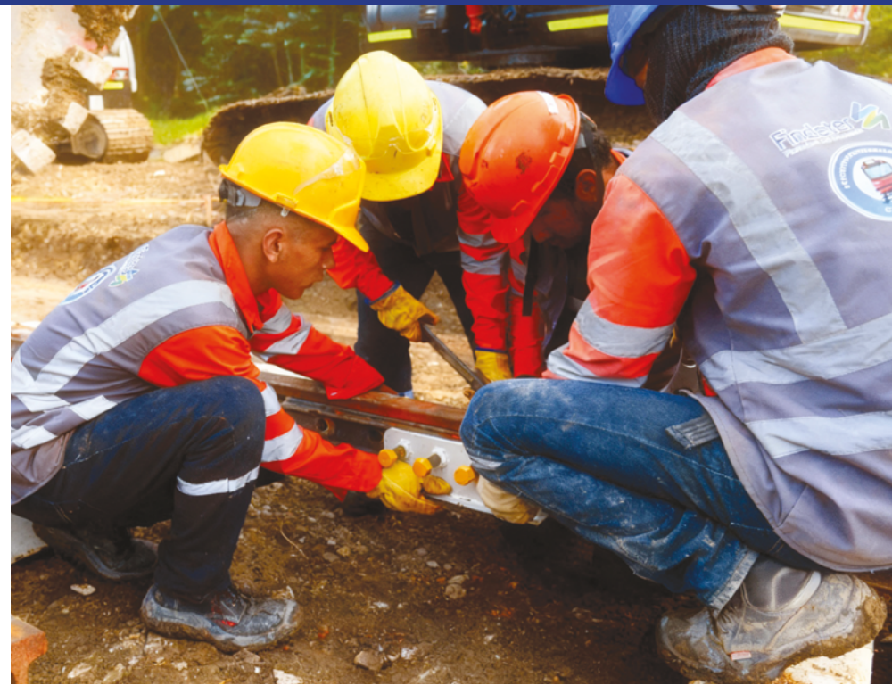
Trabajos en el tramo Tuta-Belencito.
