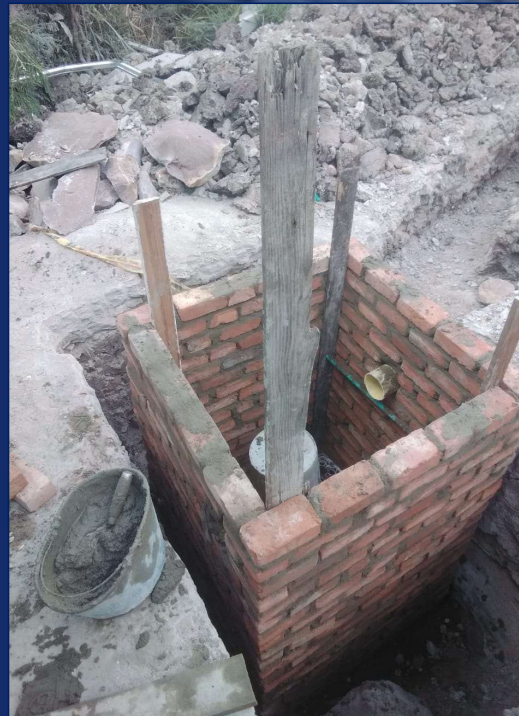
Construcción unidad filtro mixto
