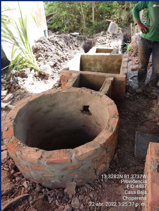
Construcción unidad FAFA
