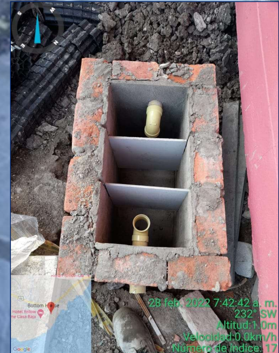
Construcción unidad trampa de grasas
