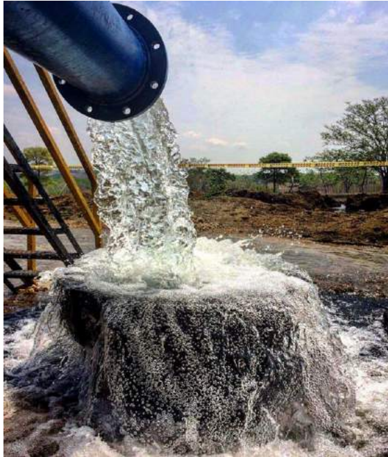
Aqueduct Pozo 51 - Srele p, Sucre
