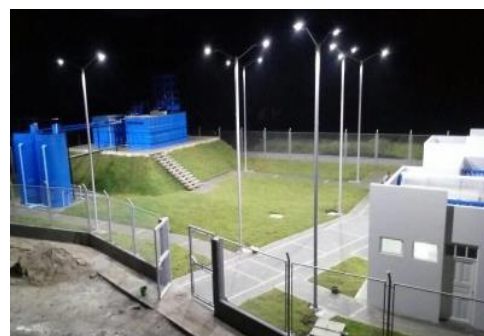
ACUEDUCTO - PLANTA AGUA POTABLE GUALMATÁN, NARIÑO
